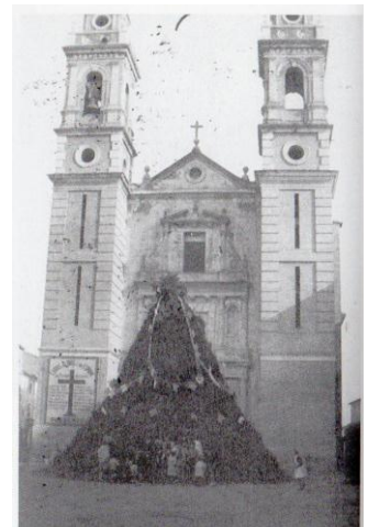
Els dos templets estan fets però el rellotge encara no està instal·lat. Fotografia de 1961
