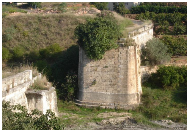
Imatges 12 i 13: Estat actual de les pilastres del pont de ferro.
